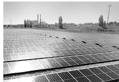
Установка собственной электростанции на базе солнечных панелей и получение сертификата ISO 14001
